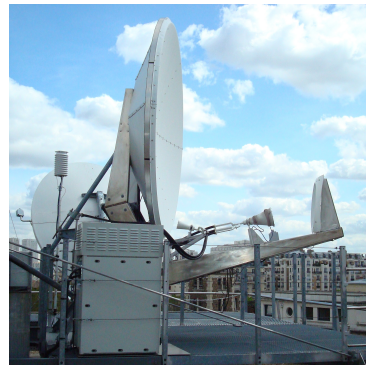
Figure 4: Paraboles de communication depuis le SYRTE/Observatoire de Paris vers le satellite Telstar11N pour les échanges bidirectionnels de partage de temps et de fréquence (TWSTFT). Photographie J. Achkar (SYRTE).
